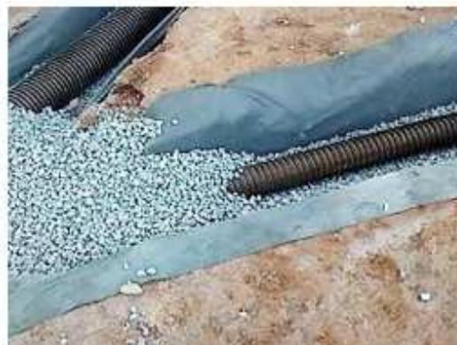
Figura 9 - Exemplo de dreno com tubo perfurado.
